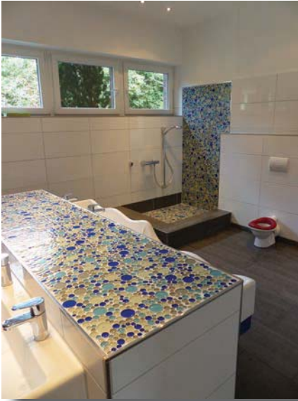
kindgerechte Sanitäranlage im Kindergarten Flüren
